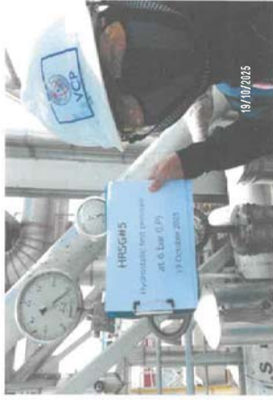
ทำการตรวจความดันที่ใช้ในการอัดเพื่อทำการHydrostatic Test 1.5 เท่าของ Maximum Working Pressure ความดันที่ใช้ 6 Bar ด้าน Low Pressure หม้อไอน้ำหมายเลข 5( HRSG-05 ) บริษัท ราชนาพัฒนา เอนเนอจี จำกัด (มหาชน) วันที่ 19 ตุลาคม 2568
