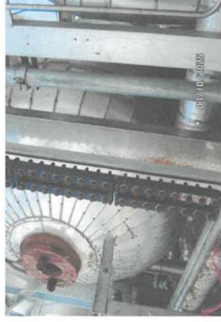
ตรวจสอบสภาพ Drum ต่างๆ ผลปกติ หม้อไอน้ำหมายเลข 6( HRS-G-06 ) บริษัท ราชพัฒนา เอ็นเนอร์ยี่ จำกัด (มหาชน) วันที่ 7 ตุลาคม 2568 .....(นายวิเศษ ทัศนธรณ์ วิศวกรผู้ตรวจทดสอบ)
