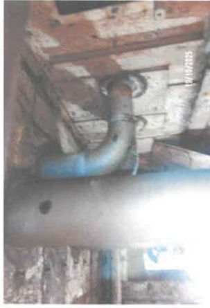
ตรวจสอบสภาพแนวเชื่อมท่อน้ำภายในหม้อน้ำ หม้อไอน้ำหมายเลข 5( HRSG-05 ) บริษัท ราชพัฒนา เ็นเนอร์ยี่ จำกัด (มหาชน) วันที่ 19 ตุลาคม 2568
