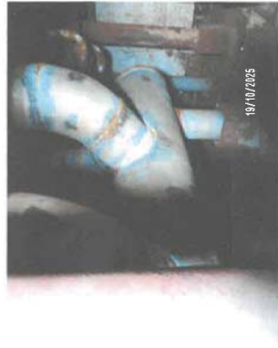
ตรวจสอบสภาพแนวเชื่อมท่อน้ำภายในหม้อน้ำ หม้อไอน้ำหมายเลข 5( HRSG-05 ) บริษัท ราชพัฒนา เ็นเนอร์ยี่ จำกัด (มหาชน) วันที่ 19 ตุลาคม 2568
