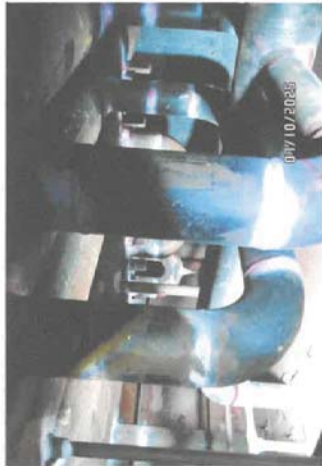
ตรวจสอบสภาพแนวเชื่อมท่อภายในหม้อไอน้ำ หม้อไอน้ำหมายเลข 6( HRS-G-06 ) บริษัท ราชพัฒนา เอ็นเนอร์ยี่ จำกัด (มหาชน) วันที่ 7 ตุลาคม 2568 .....(นายวิเศษ ทัศนธรณ์ วิศวกรผู้ตรวจทดสอบ)
