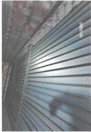
ตรวจสอบสภาพท่อไอน้ำด้าน High Pressure หลังทำการรั่วหลังอัดน้ำที่ความดันที่กำหนด ด้าน High Pressure หม้อไอน้ำหมายเลข 5( HRSG-05 ) บริษัท ราชพัฒนา เอ็นเนอร์ยี่ จำกัด (มหาชน) วันที่ 19 ตุลาคม 2568
