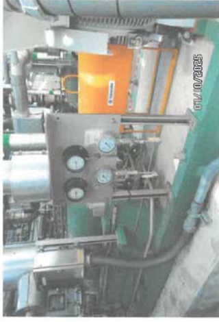
ตรวจสอบระบบ Boiler Feed Pump ผลปกติ หม้อไอน้ำหมายเลข 6( HRS-G-06 ) บริษัท ราชพัฒนา เอ็นเนอร์ยี่ จำกัด (มหาชน) วันที่ 7 ตุลาคม 2568
