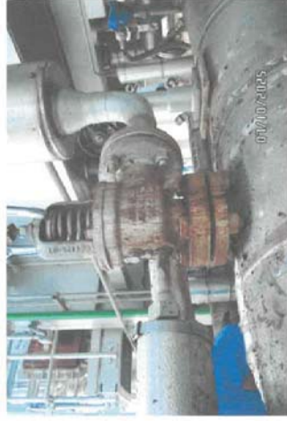
ตรวจสอบSafety Valve ต่างๆทำงานตามค่าที่กำหนด หม้อไอน้ำหมายเลข 6( HRS-06 ) บริษัท ราชพัฒนา เอ็นเนอร์ยี่ จำกัด (มหาชน) วันที่ 7 ตุลาคม 2568
