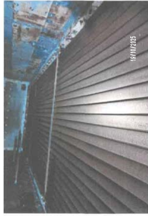
ทำการตรวจความดันที่ใช้ในการอัดเพื่อทำการHydrostatic Test 1.5 เท่าของ Maximum Working Pressure ความดันที่ใช้ Test 6 Bar ด้าน Low Pressure หม้อไอน้ำหมายเลข 5( HRSG-05 ) บริษัท ราชนาพัฒนา เอนเนอจี จำกัด (มหาชน) วันที่ 19 ตุลาคม 2568
